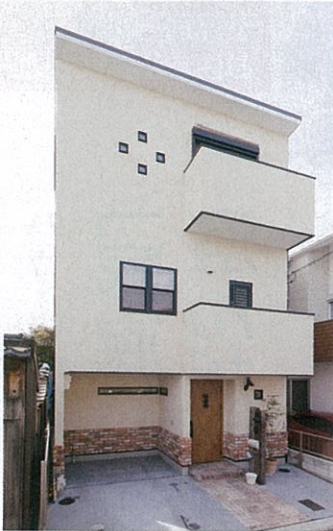
隣家が迫り間口が狭いSさんの敷地。外から見える窓を小さくして、防犯の面でも安心
